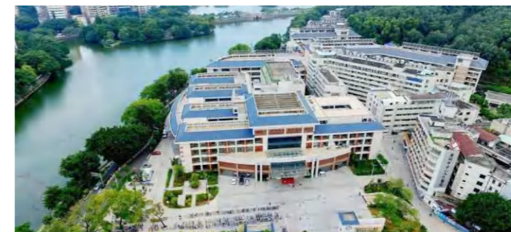
惠州市中心人民医院 Huizhou Municipal Central Hospital
